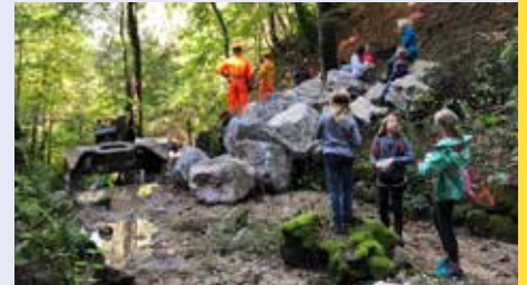
Die grosse Baggerzange ruht auf einer Betonstufe aus den 1930er-Jahren, auch wir machen eine Znünpause.
